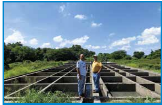
Foto 32. Reactores anaeróbicos (Tanques Imhoff) de la Planta de Tratamiento de Aguas Residuales (PTAR) El Viejo. ENACAL, El Viejo.
