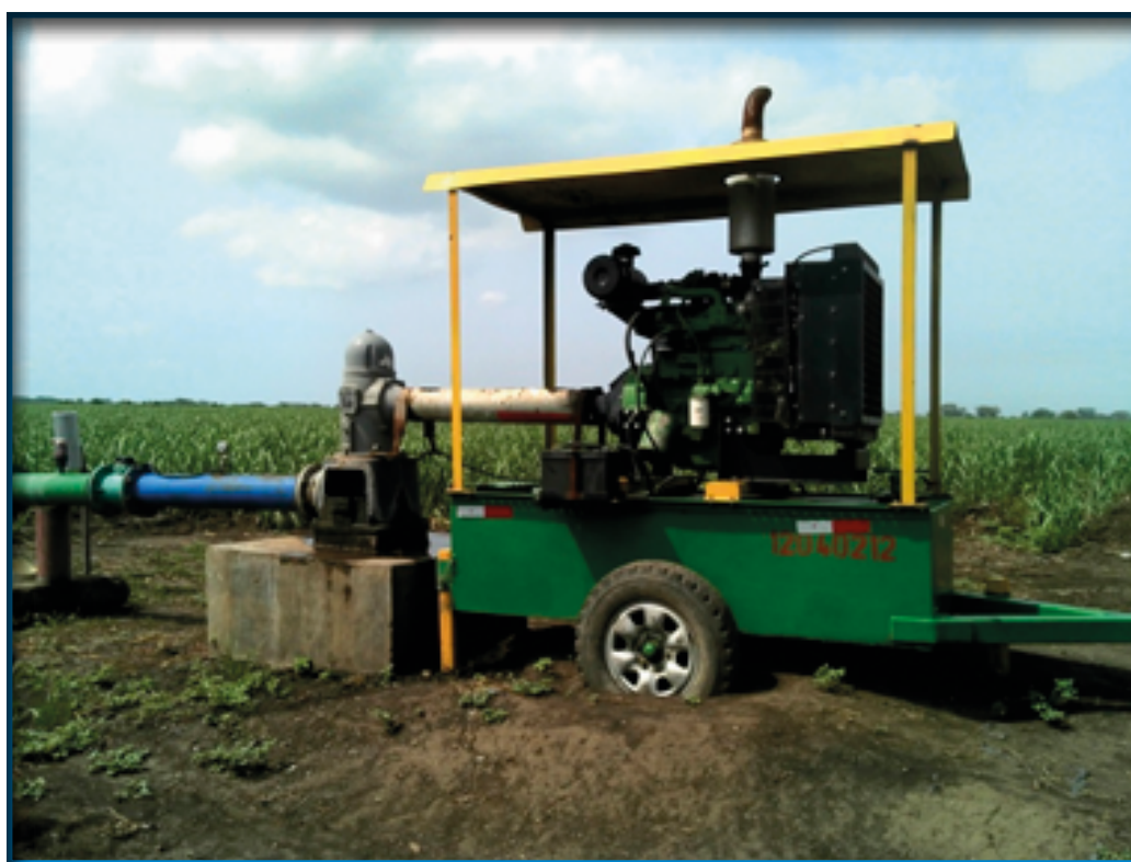
Foto 21. Abastecimiento del sector agrícola, explotación de pozo con bomba de diésel en finca ubicada en El Realejo.
