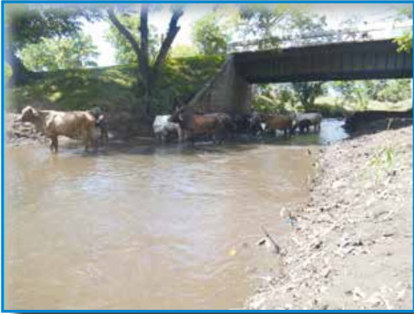
Foto 10. Río San Isidro, puente en El Realejo.
