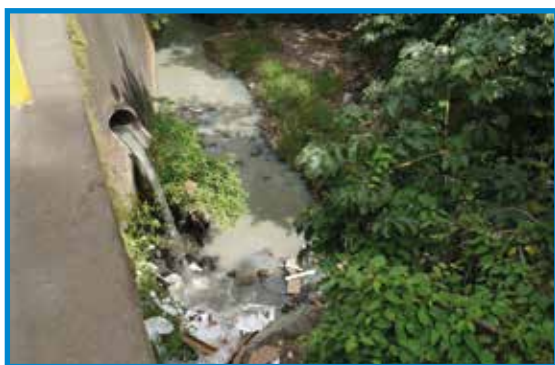
Foto 34. Drenaje de aguas servidas sin tratar vertidas al río Chiquito.
