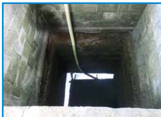
Foto 27. Pozo excavado, nivel freático somero, ubicado en la parte baja de la cuenca, en El Viejo.
