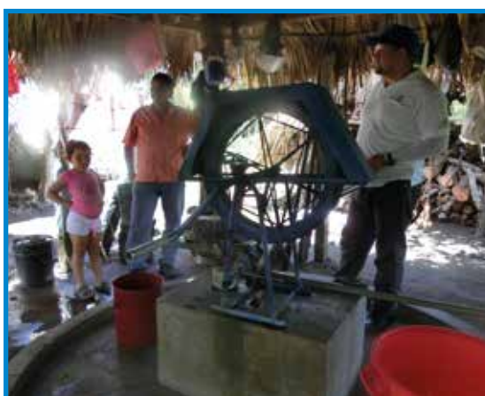
Foto 25. Pozo perforado, sellado y conectado a una bomba de mecate, ubicado en El Viejo.
