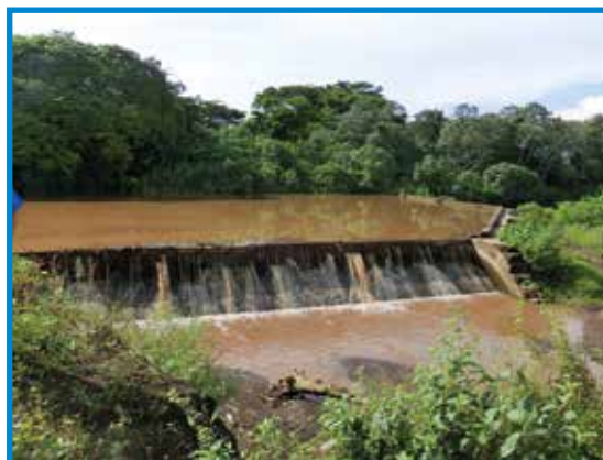
Foto 50. Presa de madera y barras de acero, ubicada en fincas de Chichigalpa durante el verano. Ingenio San Antonio, Chichigalpa.
