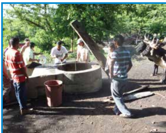
Foto 24. Pozo excavado, abastecimiento familiar, ubicado en Lechecuagos, León.
