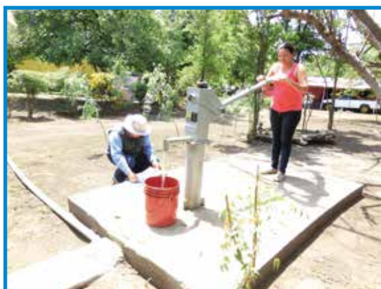
Foto 22. PPEBM en Chacaraseca, León (con bomba manual Indian Mark II, muy común en la zona).
