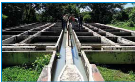
Foto 33. Vista panorámica de dos tanques Imhoff con flujo paralelo, en la Planta de Tratamiento de Aguas Residuales (PTAR) Chichigalpa. ENACAL, Chichigalpa.
