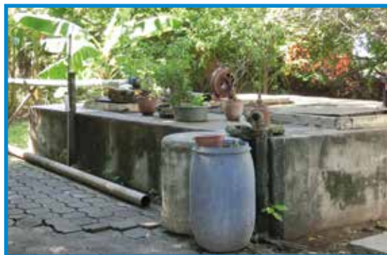
Foto 29. Estación de bombeo de aguas residuales en Corinto.
