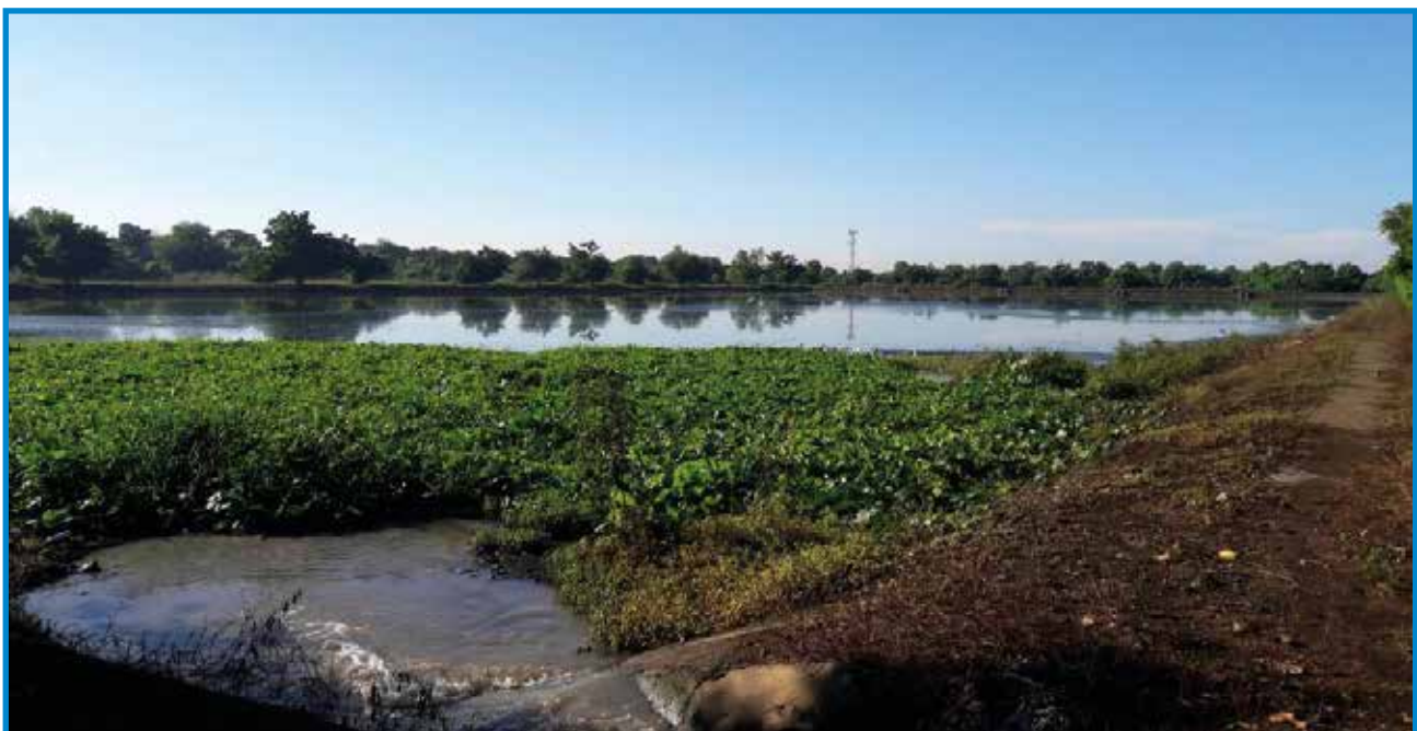
Foto 30. Vista panorámica de una de las lagunas de estabilización de la Planta de Tratamiento de Aguas Residuales (PTAR) ENACAL El Cementerio, Chinandega.
