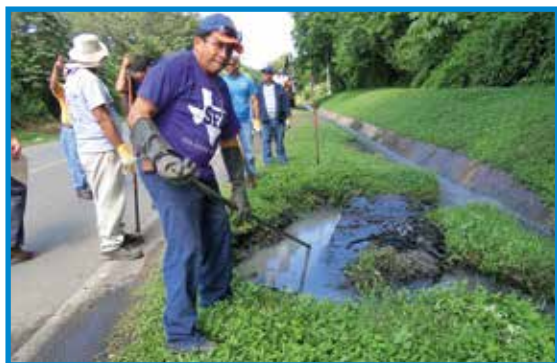
Foto 31. Personal de ENACAL eliminando la obstrucción del manjol ubicado cerca del Puente Miguel Espinales.
