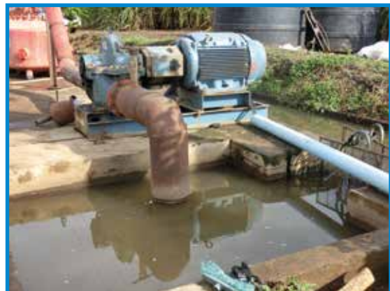
Foto 53. Sistema de aprovechamiento de agua superficial para el goteo. Ingenio San Antonio, Chichigalpa.
