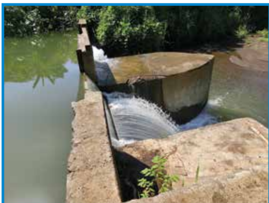
Foto 49. Presa fija, de mampostería, con un vertedero al centro, ubicada en fincas de Chichigalpa.
