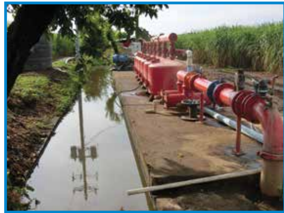
Foto 51. Filtro de arena para aprovechamiento de agua superficial para sistema de riego por goteo. Ingenio San Antonio, Chichigalpa.
