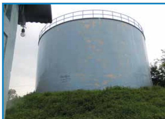
Foto 28. Tanque de almacenamiento de ENACAL en El Viejo.
