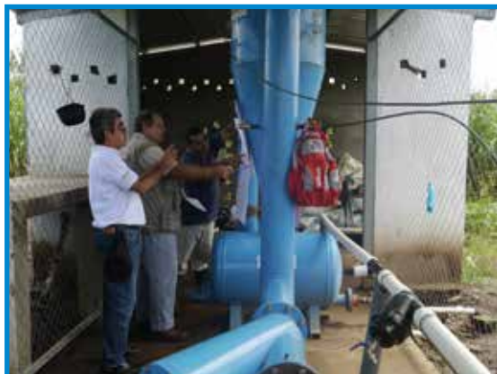
Foto 52. Filtro hidrociclón para el aprovechamiento de agua subterránea.
